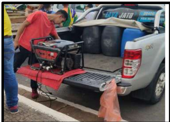
Equipamento de Geração de Energia
