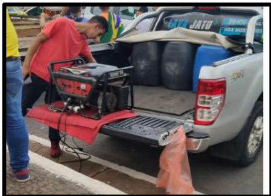
Equipamento de Geração de Energia
